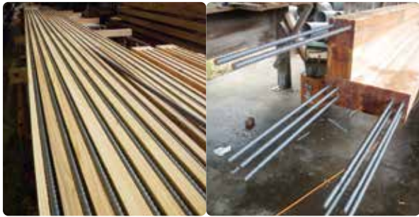
溝加工を施して鉄筋を入れた後、エポキシ樹脂接着剤で固定。以降は、通常の集成材の製造工程と同様
