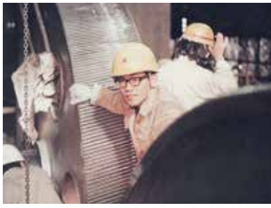
日本セメント時代、セメントミルのギア取り換え作業中の中村さん
