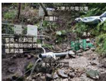
岩盤を通る地下水は電気を帯びイオン化している。湧水センサーで水の電気伝導度や水量を計測することで地下水を解析する
